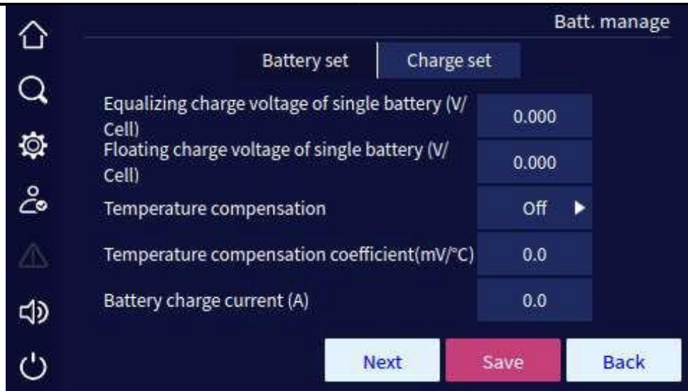
Рис 4.32 Настройка заряда АКБ 1
